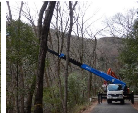
被害木の伐採(栃木市)
