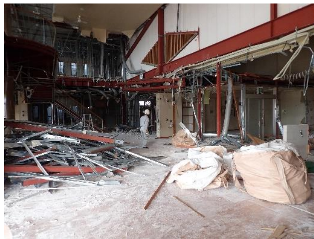
解体工事現場への立入検査
