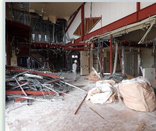
解体工事現場への立入検査
