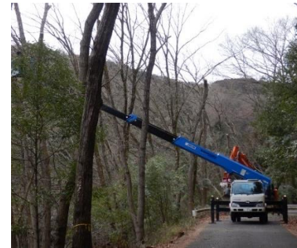
被害木の伐採(栃木市)
