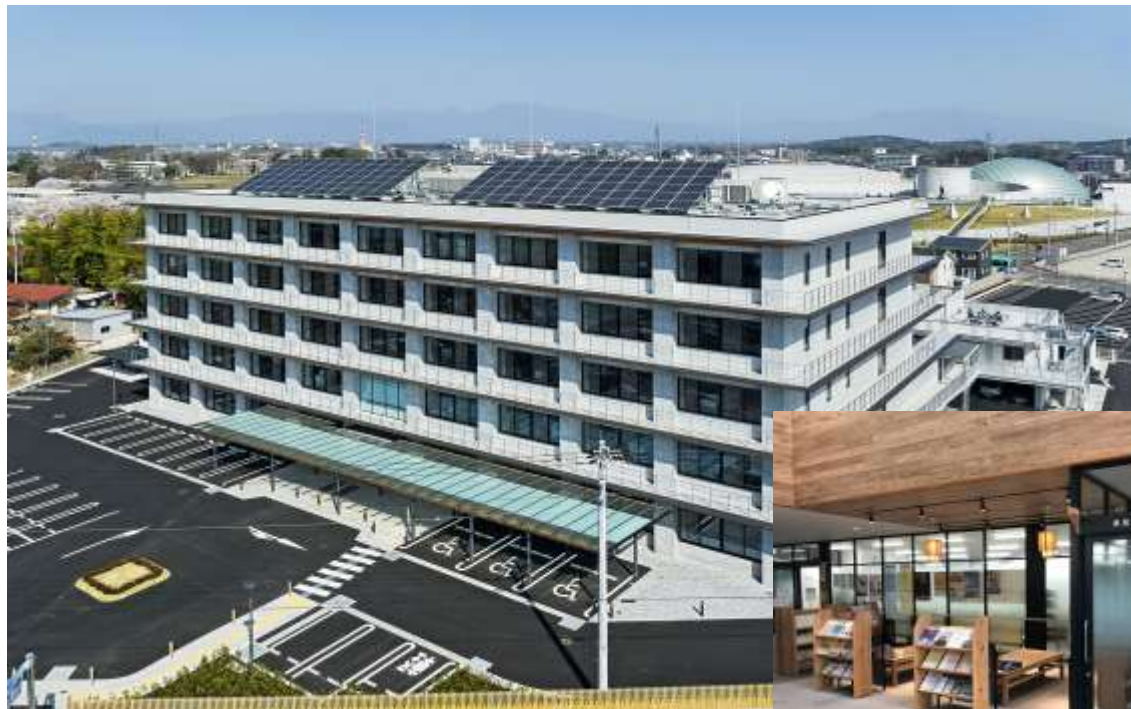
那須庁舎全景（令和5（2023）年3月供用開始）
