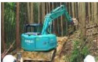
森林作業道の開設
