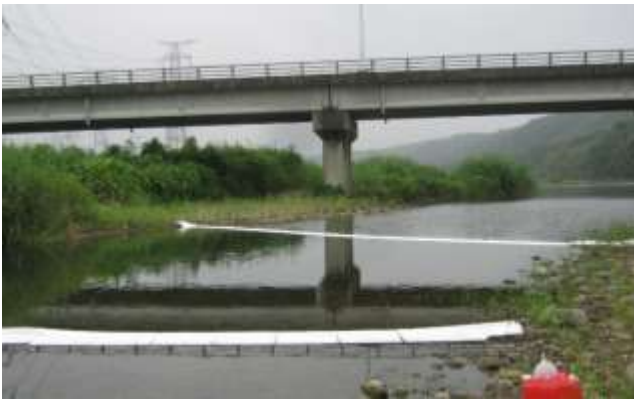
異常水質事故への対応（オイルマットの設置）
