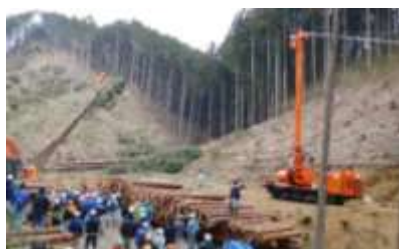
タワーヤーダによる集材
