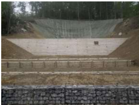
復旧工事の完了状況 (那須町 明神)
