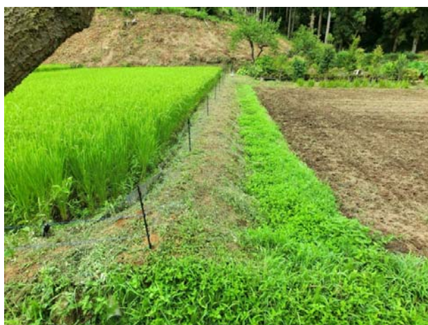
支柱設置完了
