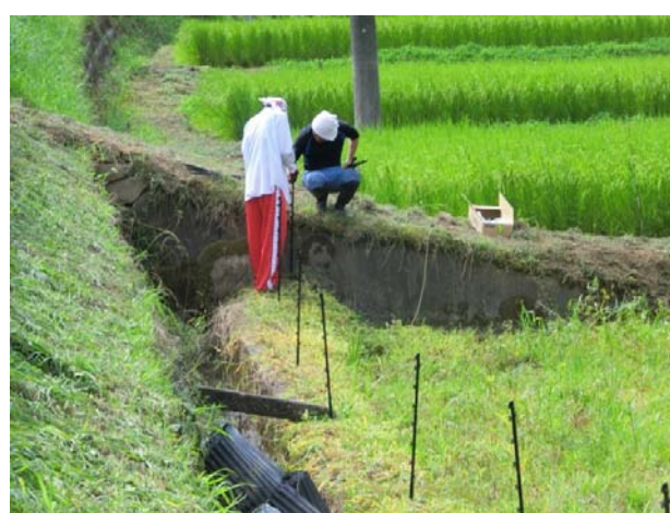
設置作業開始 支柱打ち込み
