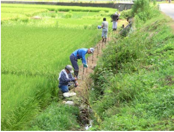
支柱に電牧線を架設
