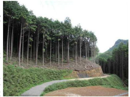
林道の整備状況（日光市）
