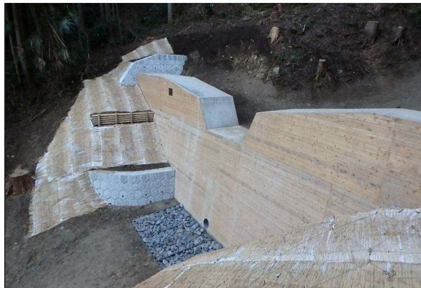
残置式間伐材型枠 関山 (那須町)
