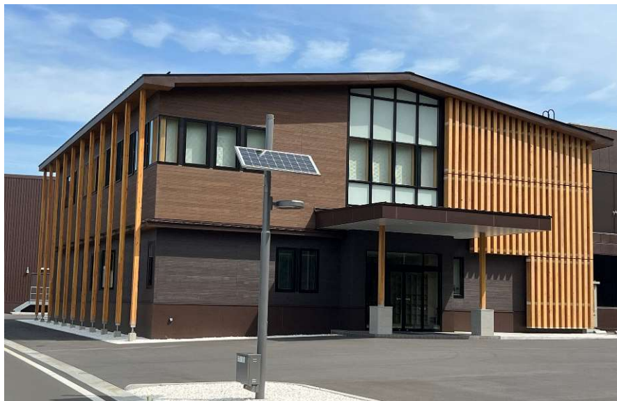
エコグリーンとちぎ 管理棟（那珂川町）【木造】
