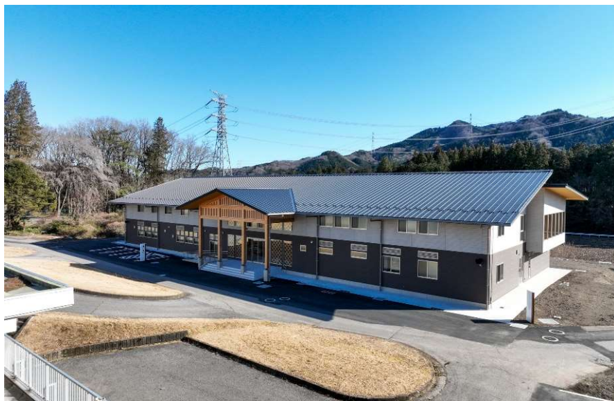
林業大学校研修・研究棟（宇都宮市）【木造】
