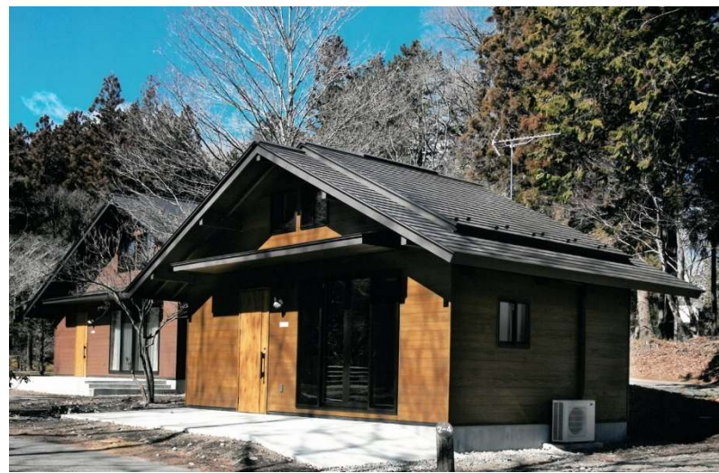
図-6 日光だいや川公園 キャビン棟（日光市）【木造】
