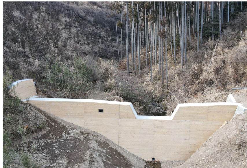
残置式間伐材型枠 真名子 (栃木市)
