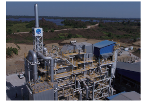
国際展開によりヤンゴンで稼働中の廃棄物処理施設
