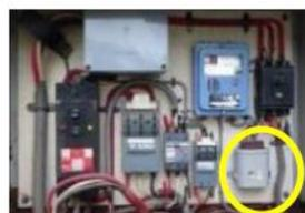
低圧分電盤内の低圧コンデンサー
