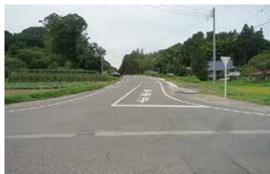
搬入路入口の現況(町道備中沢線)
