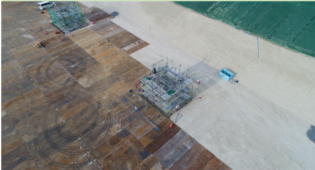
③ 埋立地（被覆施設）の中間柱の基礎設置
