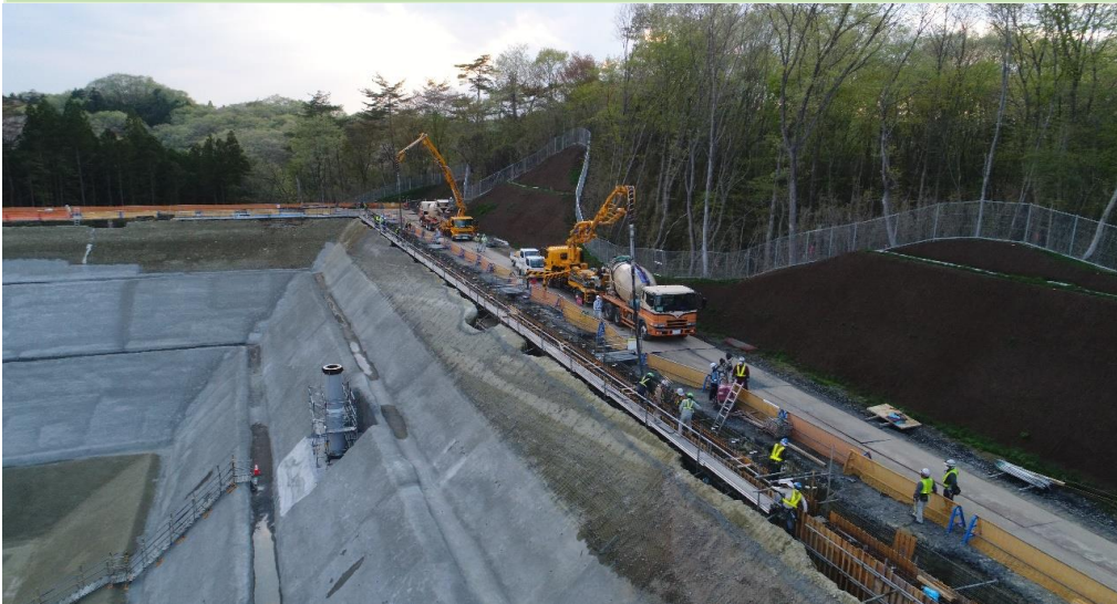
③ 埋立地（被覆施設）の外周基礎コンクリート打設
