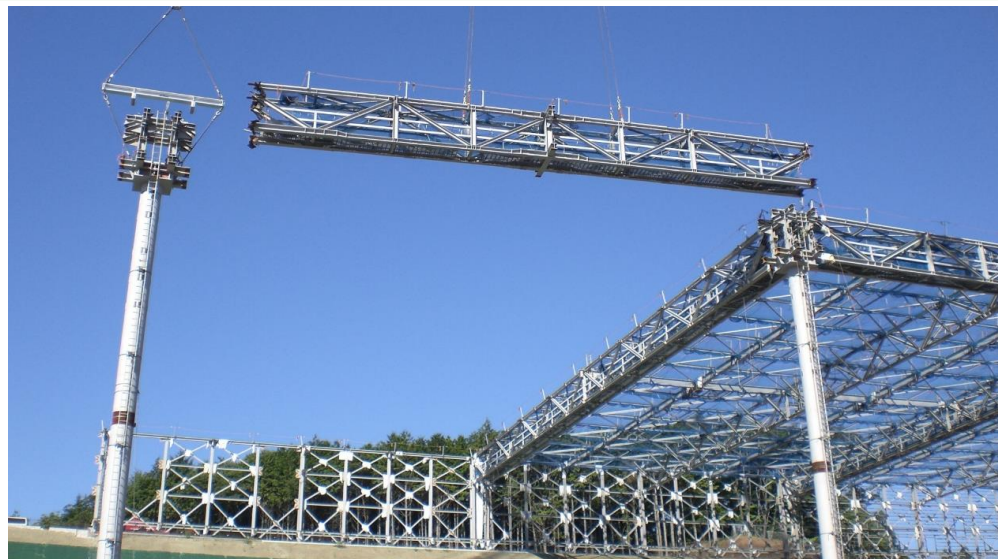
③ 大型クレーンによる鉄骨組立て作業の様子
