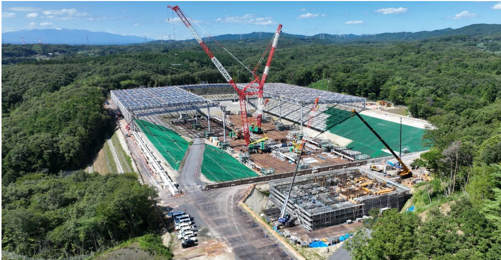
③ 大型クレーンによる鉄骨組立て作業の様子
