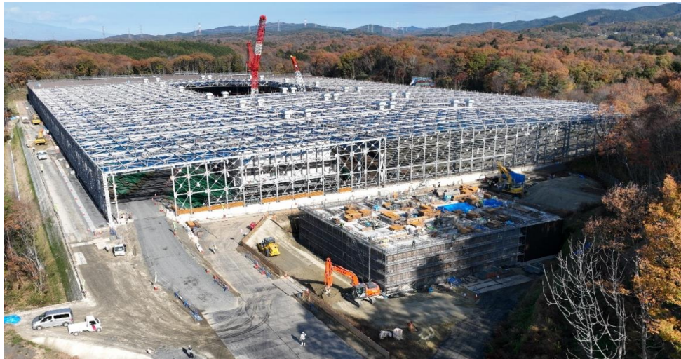
③ 屋根工事に用いる移動式足場の様子
