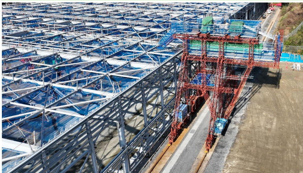
③ 屋根工事に用いる移動式足場の様子
