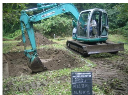
埋設箇所掘削
