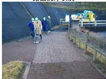
路面洗浄状況
