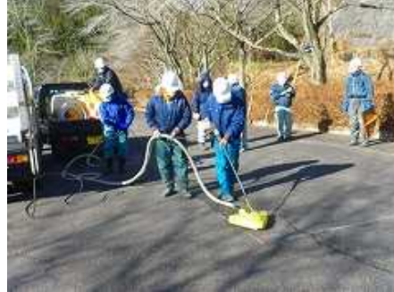
路面洗浄状況
