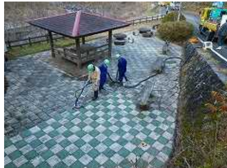
路面洗浄状況
