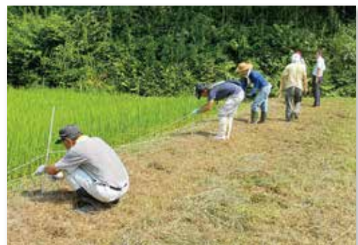
イノシシ侵入防止電気柵の設置
