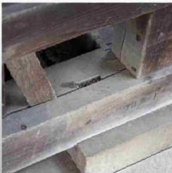
建物の床下が休息場
