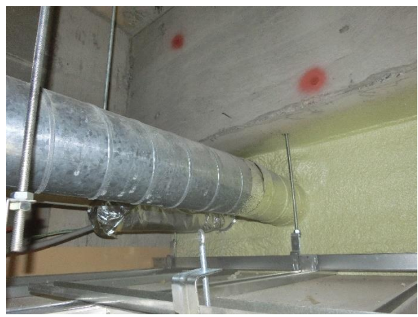
県足利庁舎設置場所状況 上：部屋内ダクト 下：ダクト管（外へ接続）
