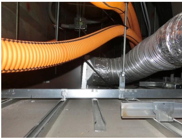
上：ダクト出口 下：部屋内ダクトからダクト間への連結部分
