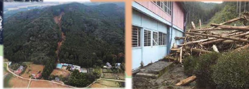
豪雨による大規模な山地災害 (栃木県宇都宮市・鹿沼市)
