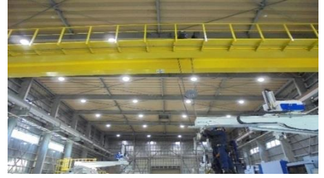
▲ 県内事業所で導入されたLED照明
