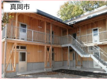
県有施設の木造・木質化
