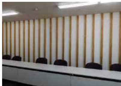
写真3 ヒノキ自体の木目を生かしながら、木ルーバーを縦均等割りに配置した壁面としました。
