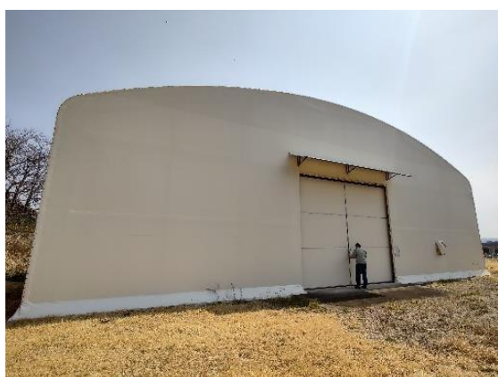
飛散防止大型テント（下水道敷地）
