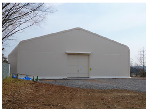
飛散防止大型TENT(下水処理場敷地)
