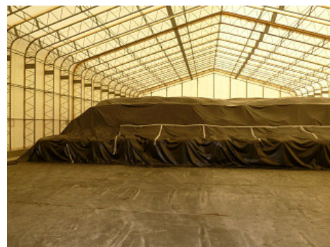
溶融スラグ等の保管(テント内部)
