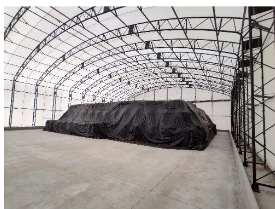
溶融スラグ等の保管（テント内部）
