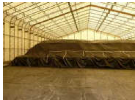
溶融スラグ等の保管(テント内部)
