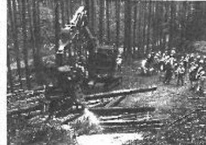
ワラタ社の高性能ハーベスタH424を用いた採材作業
