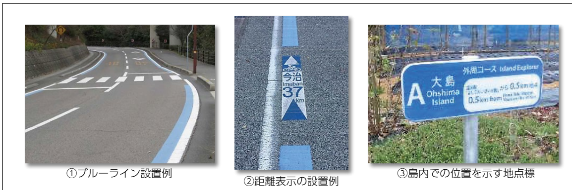
走行環境の整備事例(しまなみ海道サイクリングロード) 【出典:国土交通省資料】
