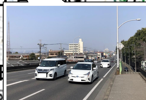
鶴田跨線橋(栃木街道)
