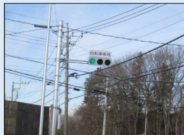
自転車専用信号機の設置例
