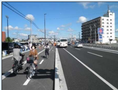
自転車通行空間の整備（自転車道）
