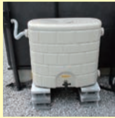
雨水貯留タンク
