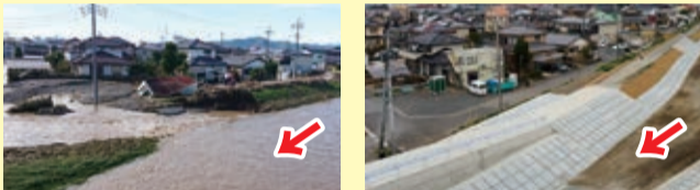
令和元年東日本台風で甚大な被害が生じた秋山川(佐野市)では、同様の災害を防ぐための河川整備を実施中。被害(左)と整備後(右)
