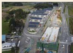
▲バイパス工事の様子
