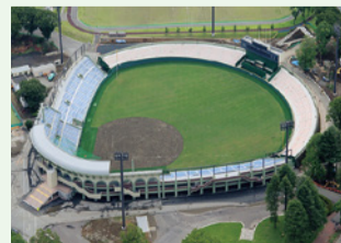
改修工事後の野球場(本球場)
