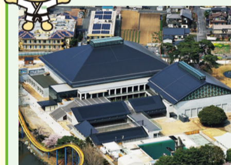
完成した武道館
