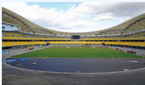
芝張りを行っているフィールド
