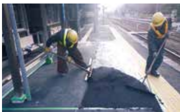
ホームの修繕(わたらせ渓谷鐵道)
