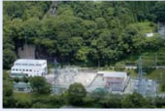
川治第一発電所
