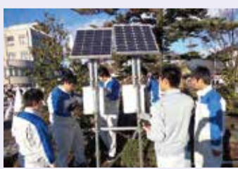
ソーラーパネルの設置作業
