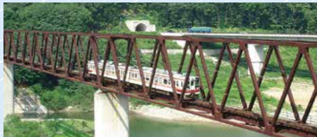
五十里湖に架かる長さ約240mの湯西川橋梁。車窓からの眺望はぜひ自分の目で
