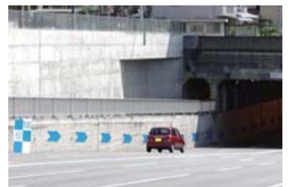
冠水チェックライン 路面冠水時に、水面に近くほどラインが水中に沈んでいくことをドライバーが確認できます
