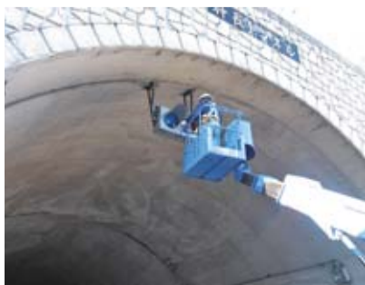
トンネル入口の信号点検の様子
