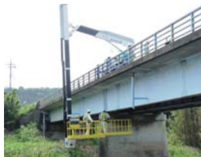
橋脚の目視点検の様子
