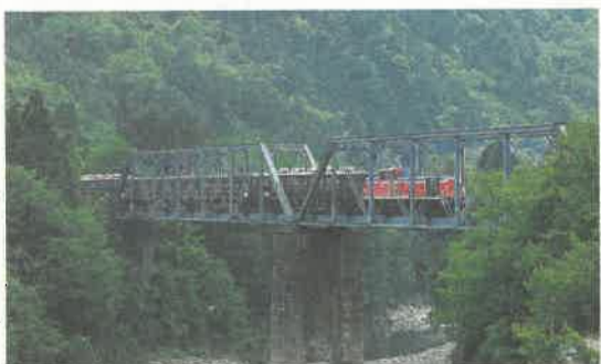
第二渡良瀬川橋梁
