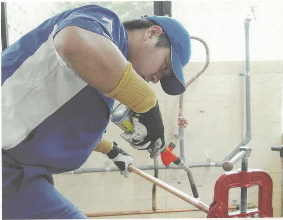
銅管を熱して指定の角度に曲げる作業。「熱した管の色で曲げるタイミングが分かる」と話す小幡さん
