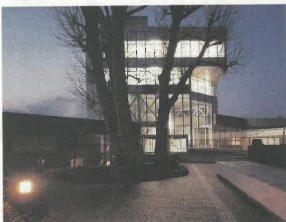
県立美術館は耐震性の向上・バリアフリー化し、昨年4月にリニューアルオープン
