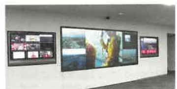
危機管理センター
