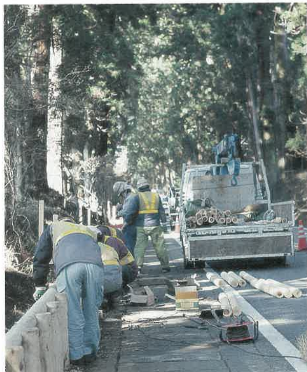
樹勢回復事業「木柵工法」 街道沿いを木柵で土留め。露出した杉の根を堆肥を混ぜた土でおおい、新しい根の再生を図ります
