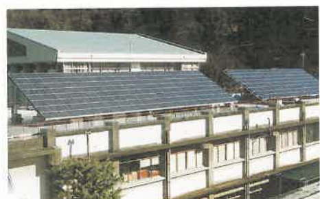
県立足利工業高校の30kW太陽光発電装置。同校の年間使用電力量の7%をまかなう予定です
