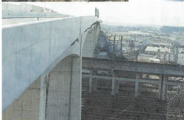
東北新幹線の上に架かる下野大橋
