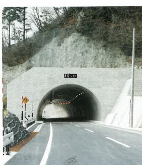
冬期、通行可能となった県道・下塩原矢板線
