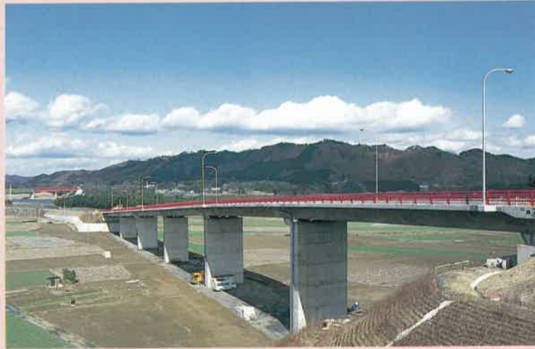
① 山あげ大橋 (烏山町・国道294号) (平成5年5月開通予定 橋長=246m) 重要無形文化財に指定されている「山あげ祭り」にちなんで名付けられたこの橋は、地震に強い「免震設計」という新しい設計方法を取り入れています。
